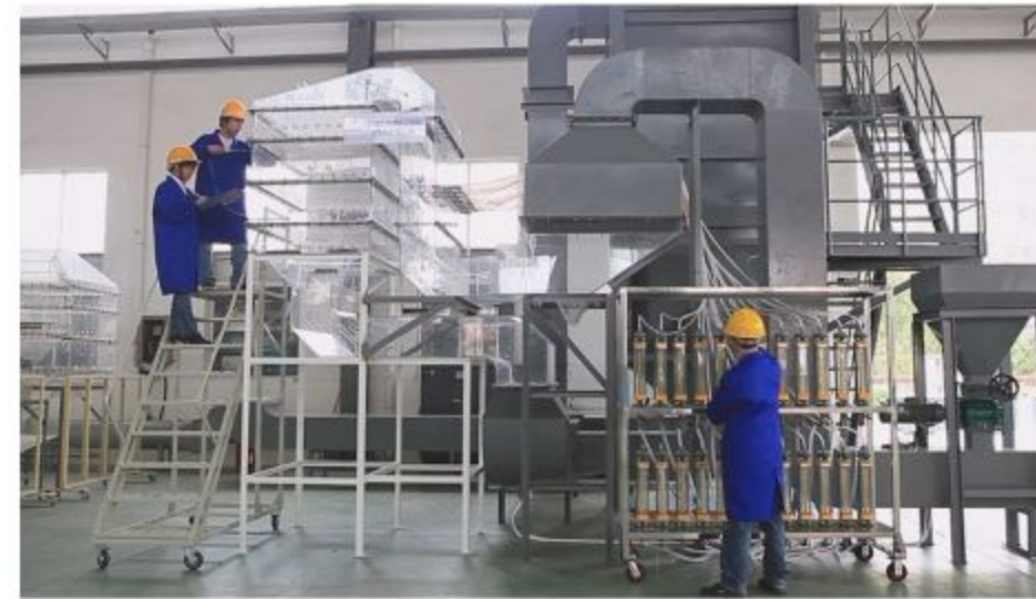
脱硝流场物模试验平台
