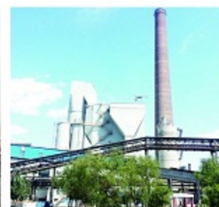
包头钢铁厂#1烧结机配套 烟气脱硫设备烟气流量测试
