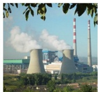
华能榆社发电有限责任公司 #4炉配套LGGH电除尘器性能试验
