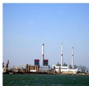
大唐黄岛电厂#6炉670MW机组 配套湿式电除尘器综合性能试验
