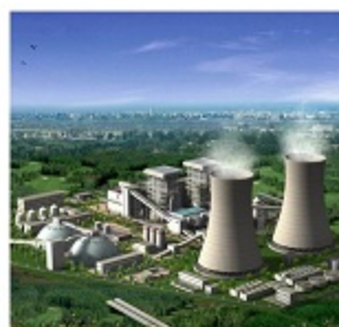
大唐清苑热电有限公司#1炉 脱硝装置冷态流场分布试验
