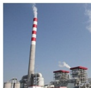
重庆石柱发电厂新建工程#1炉 350MW超临界机组配套 电除尘器性能试验
