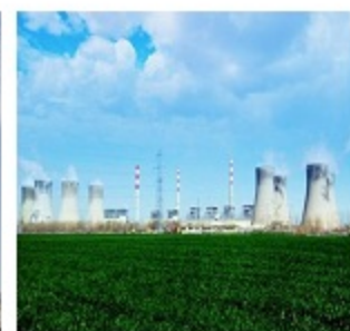
山东邹县发电厂#7炉1000MW机组 配套电除尘器性能试验
