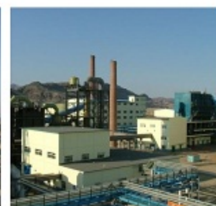
巴彦淖尔紫金有色金属有限公司 #1、#2锅炉配套 电袋复合除尘器性能试验
