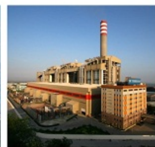
广东粤电集团有限公司沙角C电厂 #2炉配套电袋复合除尘器、 湿法脱硫设备PM 2.5 、粉尘试验
