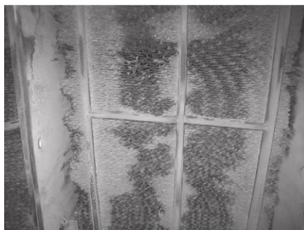
图5 空预器的积灰堵塞
